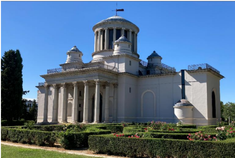
Figura 25. Edificio Villanueva en el Real Observatorio Astronómico de Madrid [7].
